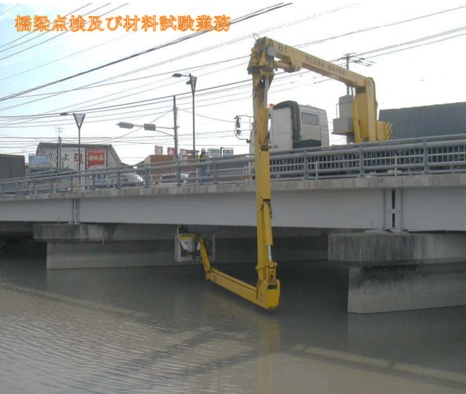
橋梁点検風景
