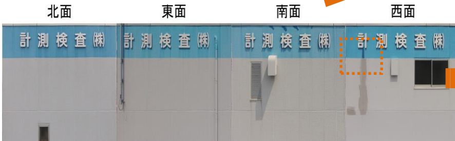
壁面撮影例・画像処理状況(展開画像)
