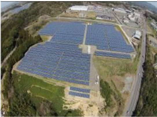
高度95m空撮画像(メガソーラー)
