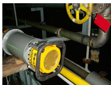
配管溶接部の撮影状況
